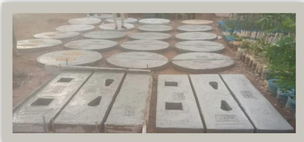
Photo 1 : Site de fabrication de dalles pour puisards, et pour la VIP à double fosses
